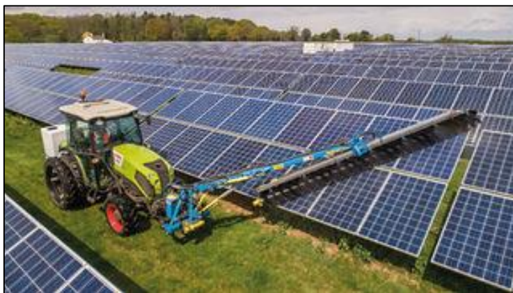
Figura 22 Mirëmbajtja e paneleve model se si duhet te jete
